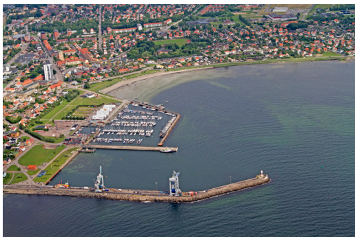
Bild som visar en konstruktion som påverkar erosion och ackumulering av sand. Källa: Henrik Nilsson, 2021.
